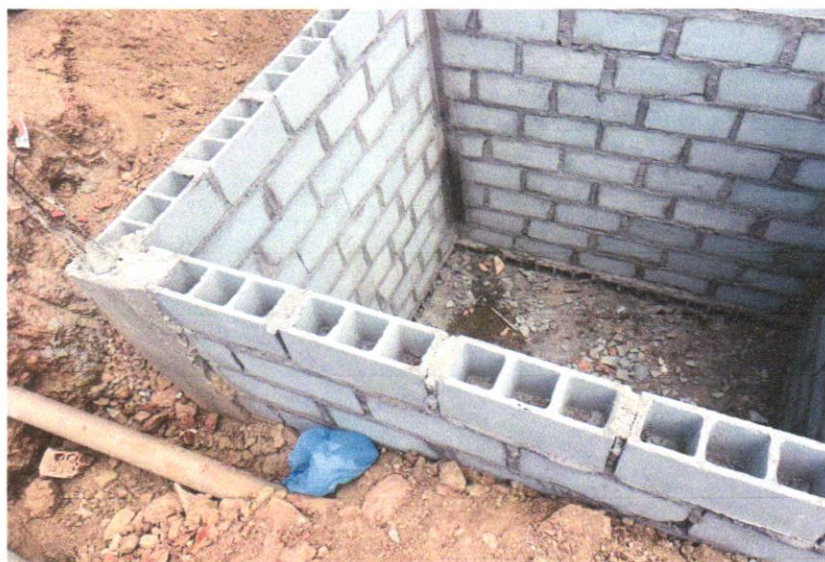
FOTO 06 - ALVENARIA DE BLOCOS DE CONCRETO ESTRUTURAL 14X19X39 CM, (ESPESSURA 14 CM) FBK = 14,0 MPA, PARA PAREDES COM ÁREA LÍQUIDA MENOR QUE 6M 2 ,
