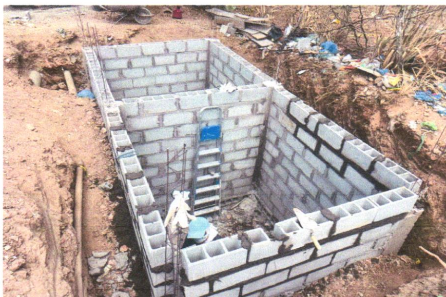
FOTO 05 - ALVENARIA DE BLOCOS DE CONCRETO ESTRUTURAL 14X19X39 CM, (ESPESSURA 14 CM) FBK = 14,0 MPA, PARA PAREDES COM ÁREA LÍQUIDA MENOR QUE 6M 2 , SEM VÃOS, UTILIZANDO PALHETA. AF_12/2014
