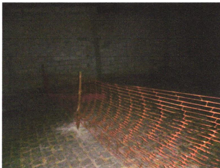
FOTO 02 - Tapume de proteção em tela de polietileno h=1,20 com bloco de concreto
