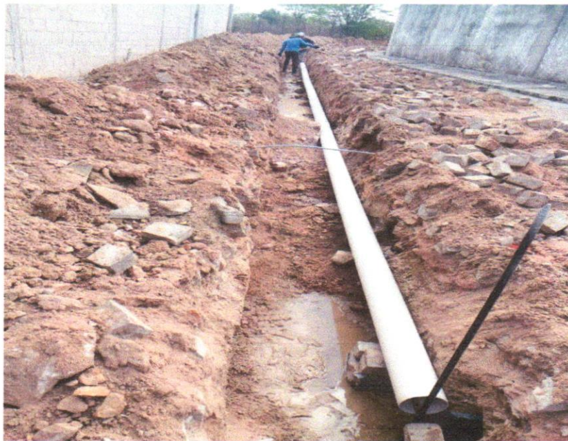
FOTO 03 - ESCAVAÇÃO MANUAL DE VALA COM PROFUNDIDADE MENOR OU IGUAL A 1,30 M
